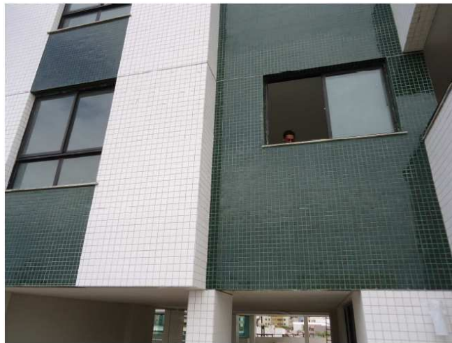
Figura 1. Vedação externa com janela de correr.
