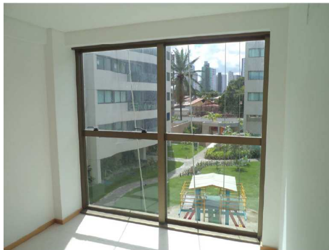
Figura 2. Vedação externa em pele de vidro.
