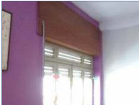
Caixas de estore
