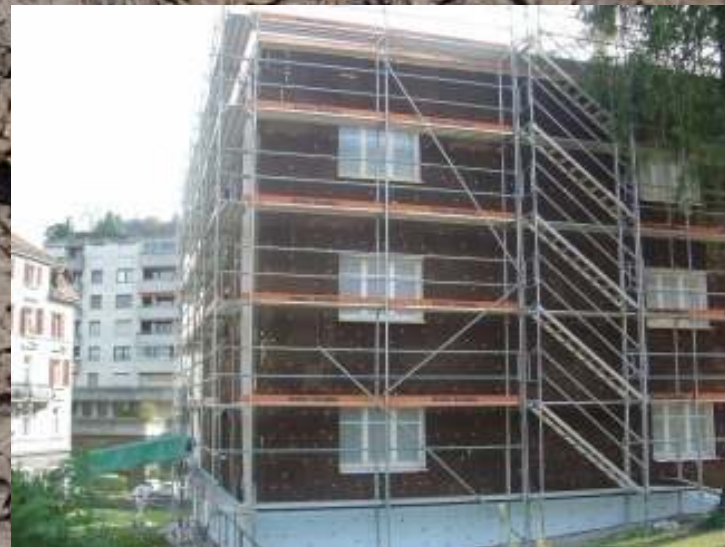
Isolamento de parede exterior
