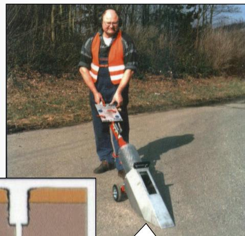
Equipamento para aquecimento dos bordos da junta
