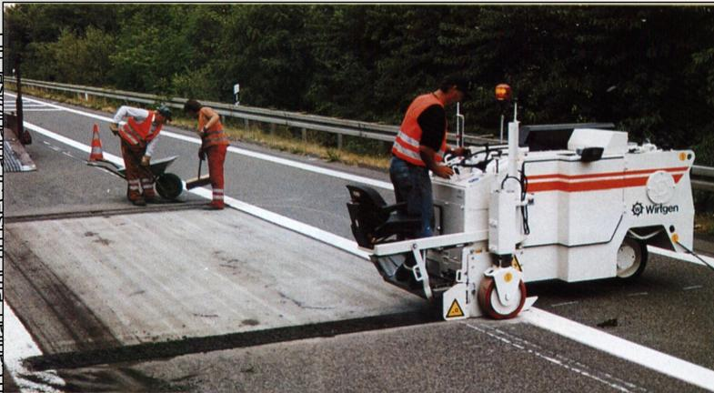
A fresagem através das extremidades de pistas individuais assegura a produção de uma borda perpendicular ao pavimento existente.
